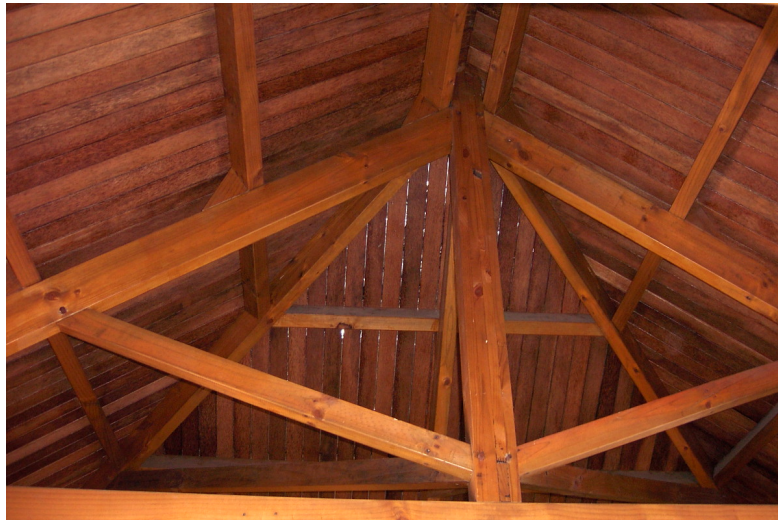
Voligeage en Cocotier sur charpente en Pinus caribaea (Nouvelle-Calédonie).
